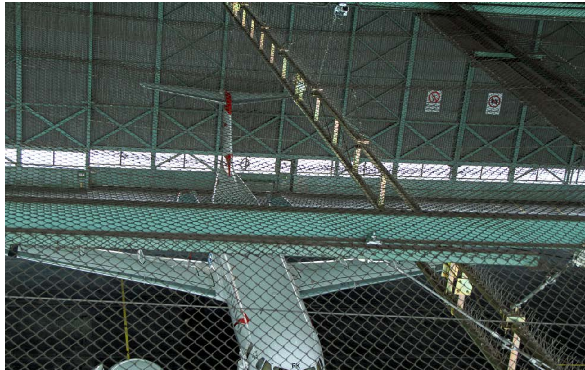
Deckenmontiertes Personensicherungssystem oberhalb des Flugzeugs, um den Arbeitern den Zugang zur gesamten Länge des Flugzeugs zu ermöglichen.
