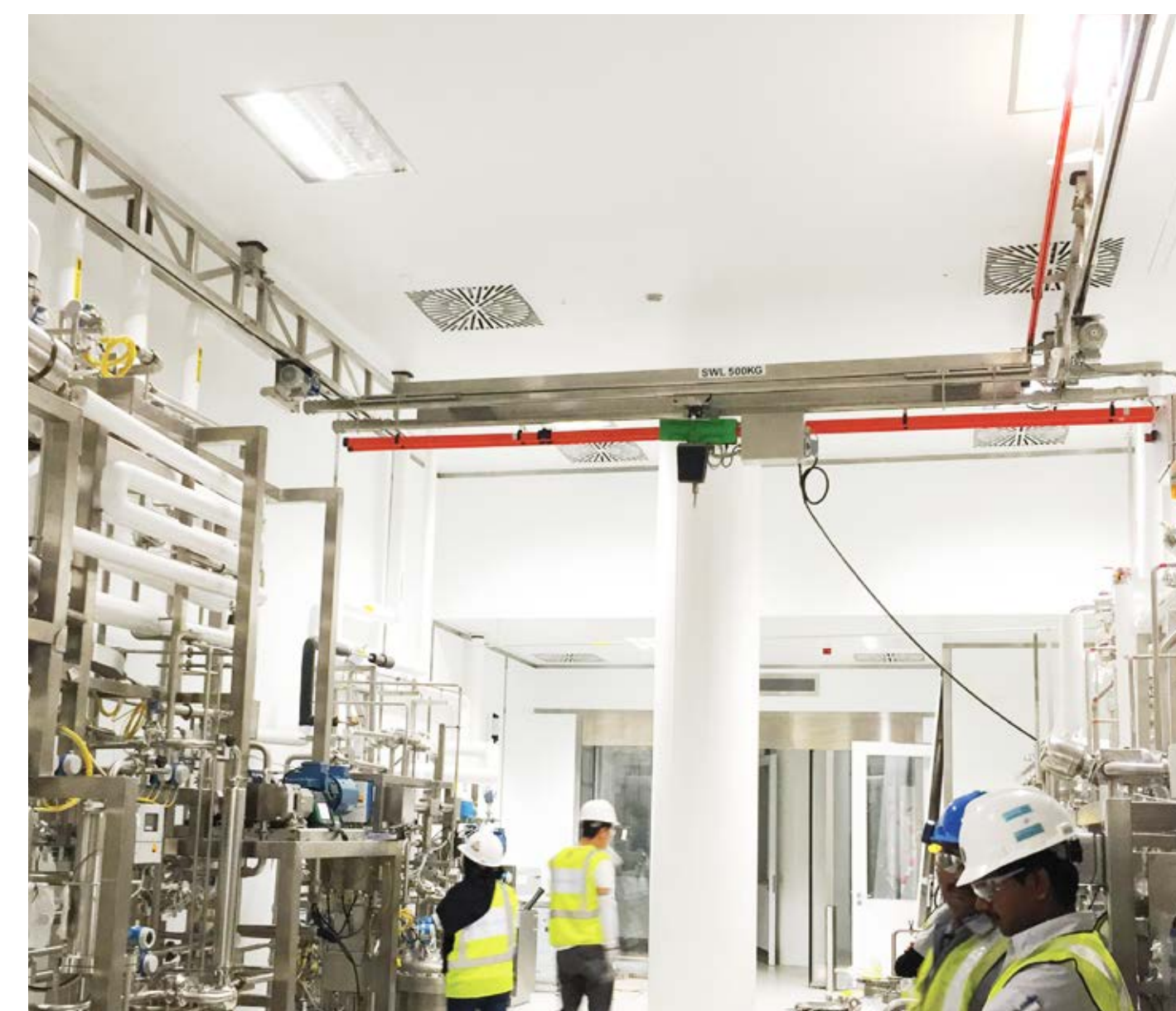
Die Fachwerkträger wurden auf Stahlträgern der bestehenden Gebäudekonstruktion in der maximal möglichen Höhe montiert.
