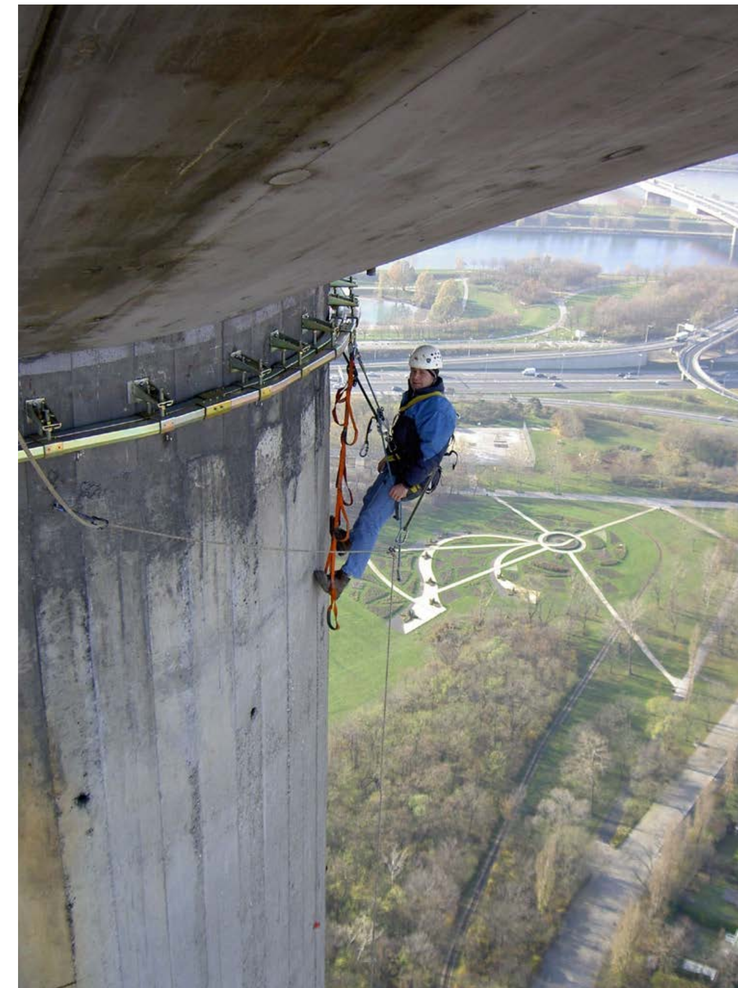
Inspektion am Donauturm in Wien. Das System wurde rund um das Gebäude mit speziellen Halterungen montiert, um die freie Bewegung im gesamten Arbeitsbereich zu ermöglichen.
